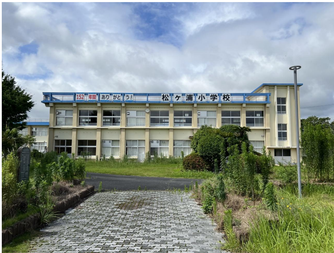
管理教室棟 南側から撮影
