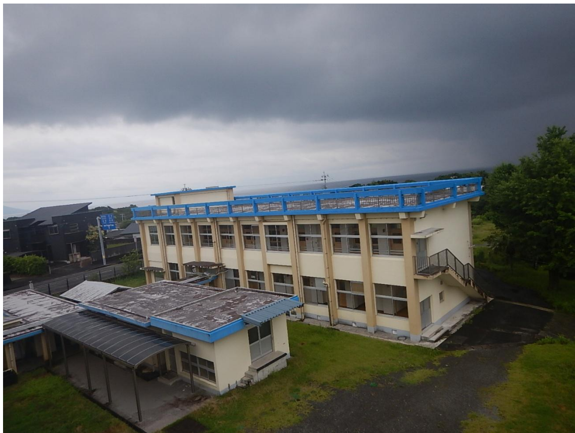
管理教室棟 北西側から撮影
