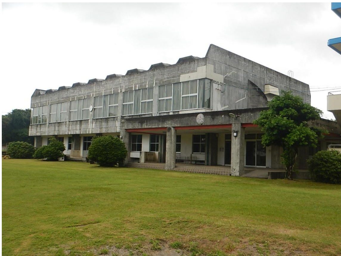
屋内運動場 南西側から撮影
