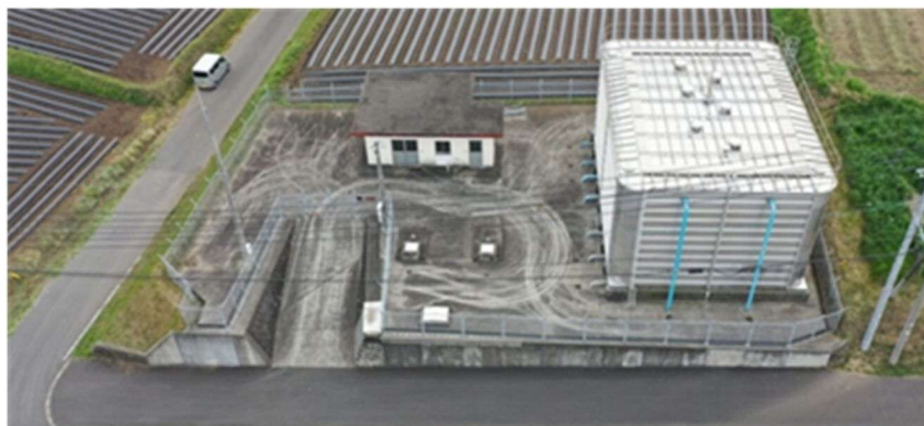
西部配水池 R5年度 遠方監視設置工事
