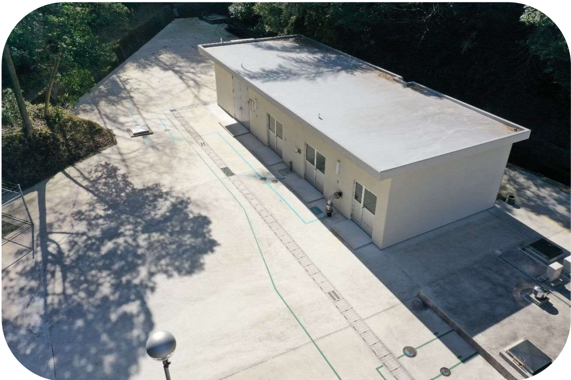
令和元年度完成 中部水源地
