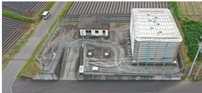
西部配水池 R5年度 遠方監視設置工事
