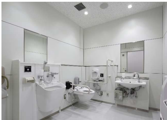
多目的トイレの事例（北本市庁舎）
