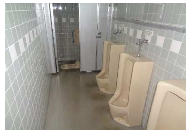
東別館 トイレ(3階男子)
