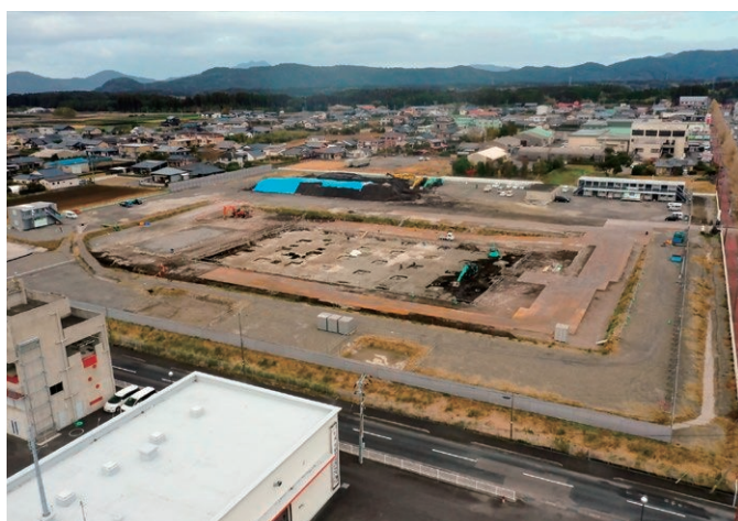
新庁舎建設工事現場の様子（全体）
