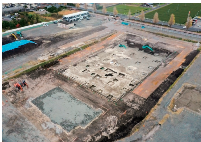
新庁舎建設工事現場の様子（附属棟側から）
