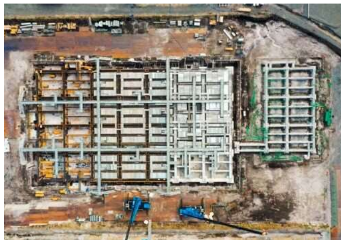
新庁舎建設工事現場の様子（2月27日時点：真上から）
