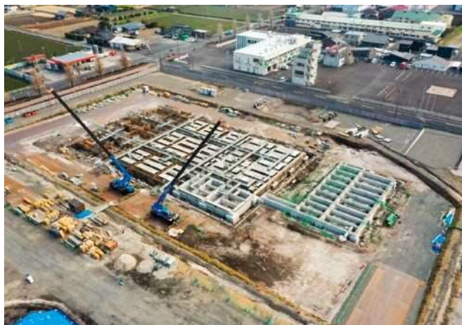
新庁舎建設工事現場の様子（2月27日時点：全体）
