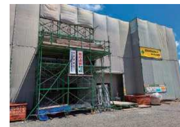
附属棟（西側から）
