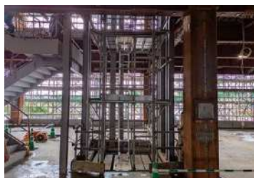
エレベーター枠組
