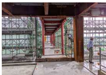
【2階】附属棟連絡通路
