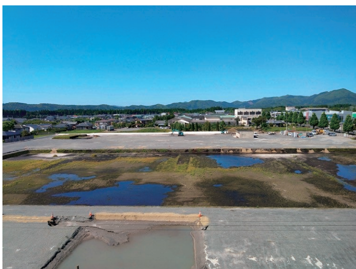
造成工事の様子（令和6.5.9撮影）
