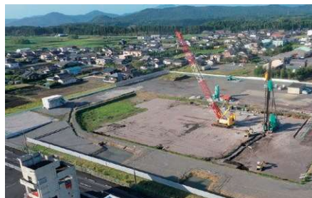
杭打ち作業の様子(10月下旬ごろ)
