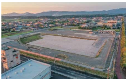
重機搬入前の様子(10月中旬ごろ)
