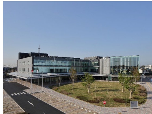
防災広場の事例
