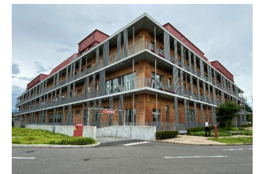
メンテナンスバルコニーの事例
