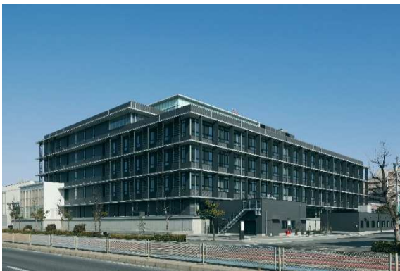
庇バルコニー・ルーバーを設置した事例(半田市庁舎)
