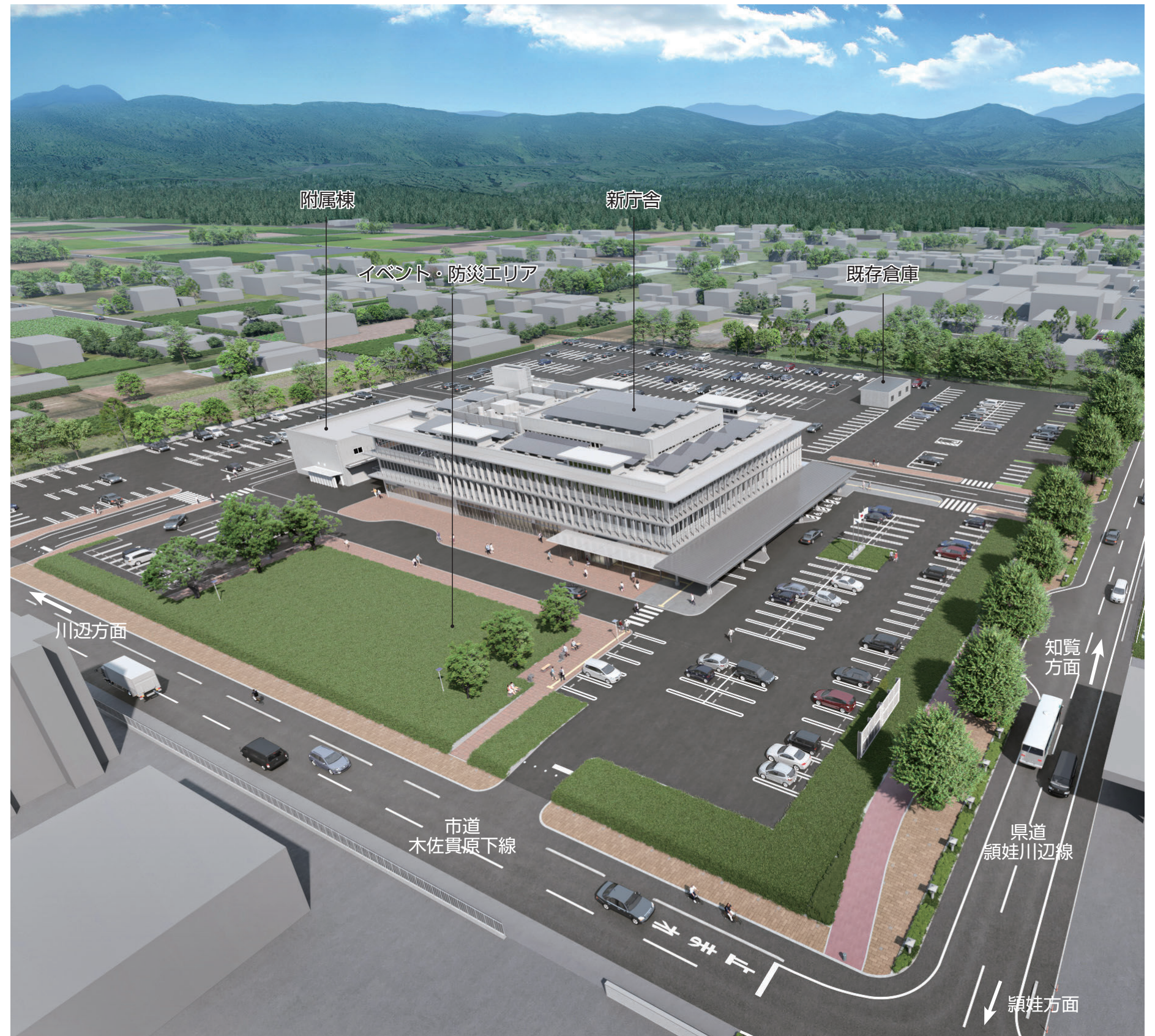
南東側から見た新庁舎全体のイメージ
