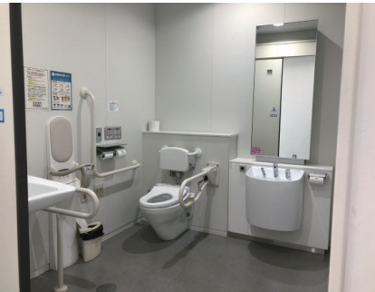
緊急呼出ボタン、オストメイトのある多目的トイレ
