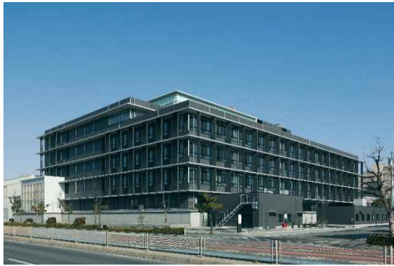
底バルコニー・ルーバーを設置した事例(半田市庁舎)
