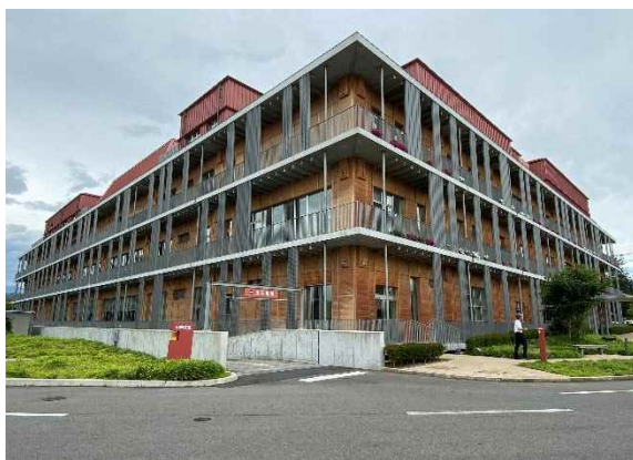
メンテナンスバルコニーの事例(安曇野市庁舎)
