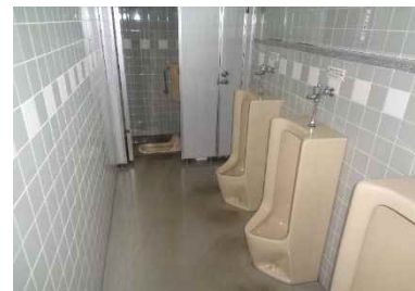
東別館 トイレ(3階男子)
