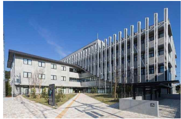
太陽光パネルをルーバーに用いた事例(瑞穂町庁舎)
