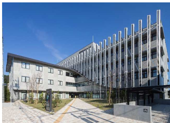
太陽光パネルをルーバーに用いた事例(瑞穂町庁舎)
