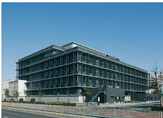
庇バルコニー・ルーバーを設置した事例(半田市庁舎)
