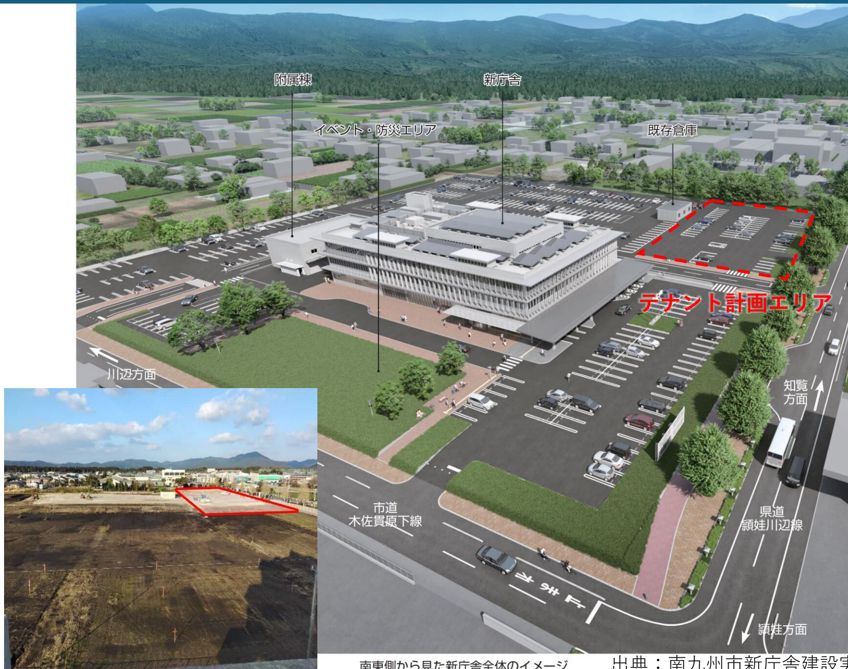
南東側から見た新庁舎全体のイメージ
