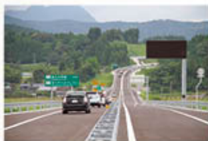
▲南薩縦貫道「川辺道路」開通
