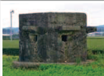
▲「トーチカ」六角形で銃眼がある陣地。鉄筋の代わりに竹筋が使われています。
