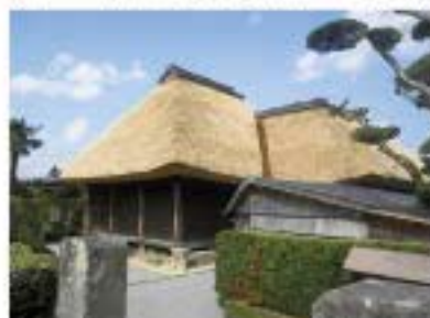
▲2月から3月にかけて総葺き替えされた知覧型二ツ家民家。
