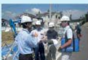
集会所新築現場立会状況
