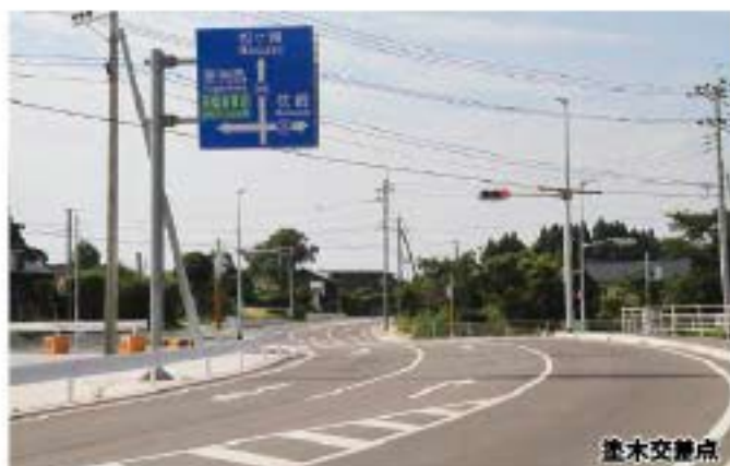
▲信号機が設置され、交通事故防止が期待されます。
