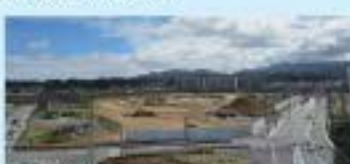
気仙沼港付近の区画整理状況
