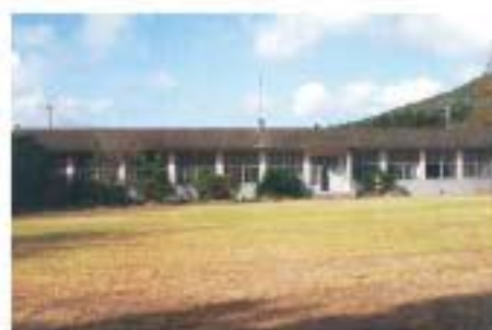
▲解体前の旧新牧小学校校舎。
