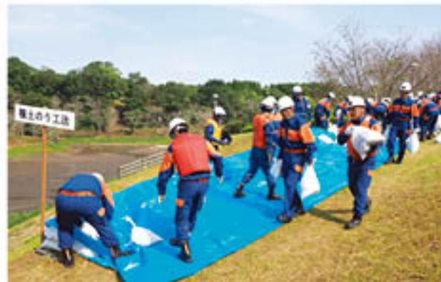
▲河川の越水を想定に護土の工法を実施する消防団員のみなさん。
