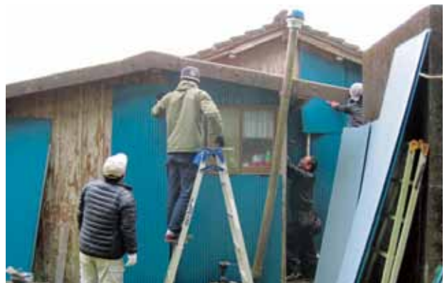
▲外壁の屋根下や窓枠部分にピタッと合うようにトタン板を切っていくなど、手際よく作業されていました。
