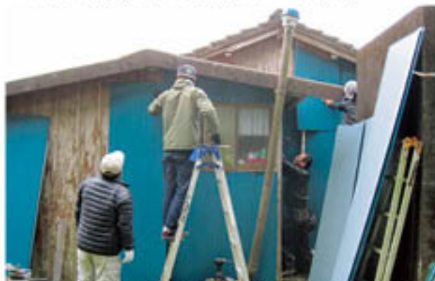
▲外壁の覆板下や窓枠部分にピタッと合うようにトタン板を切っていくなど、手際よく作業されていました。
