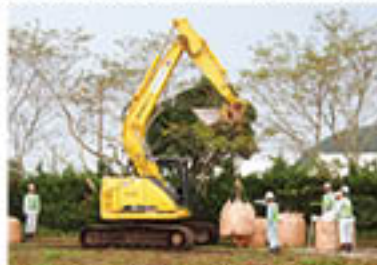
▲鹿児島県建設業協会加世田支部による大型機土のう工法
