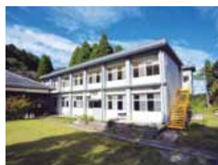
鉄筋校舎は機能性を重視し、多目的に使えるスタディールームや宿泊機能を備え居住空間に改修。
