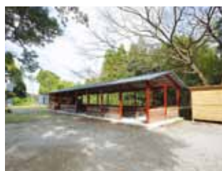
鉄筋校舎横にガーデンキッチンと半屋外仕様のダイニングを新設。約40人までの食事に対応可能。
