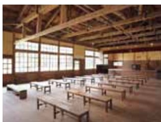
木造講堂は建造当時の姿に戻すコンセプトで修復と改修を実施。小規模な講演会などで利用いただけます。
