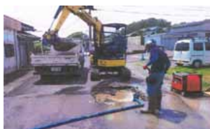
▲老朽化した水道管の漏水工事現場
