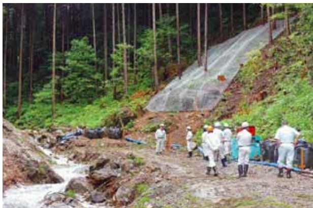
▲危険箇所をパトロールする建設同友会の方々
