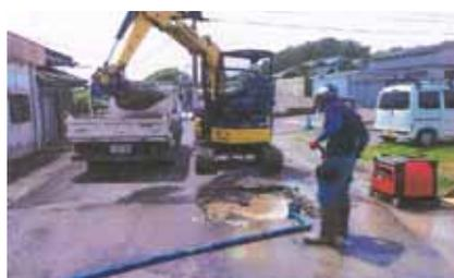
▲老朽化した水道管の漏水工事現場
