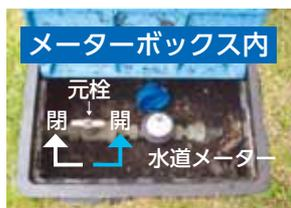
2. 寒波時に給水管が破裂した場合は、元栓を止めて修繕を依頼しましょう。元栓は時計回りに回すと水を止めることができます。
