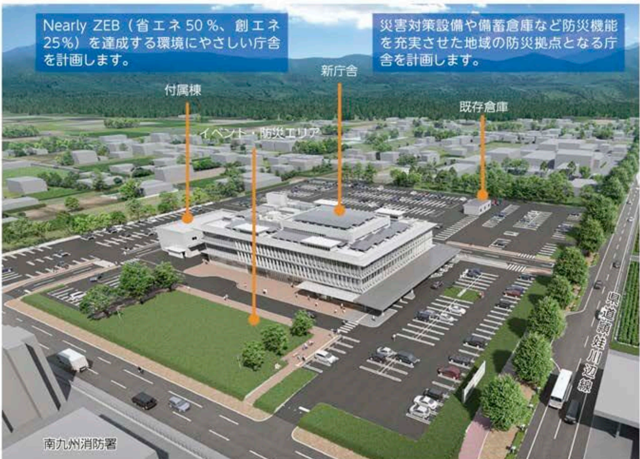
■南東側から見た新庁舎全体のイメージ
