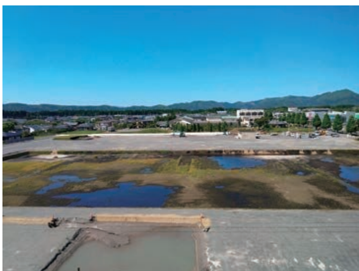
造成工事の様子（令和6.5.9撮影）
