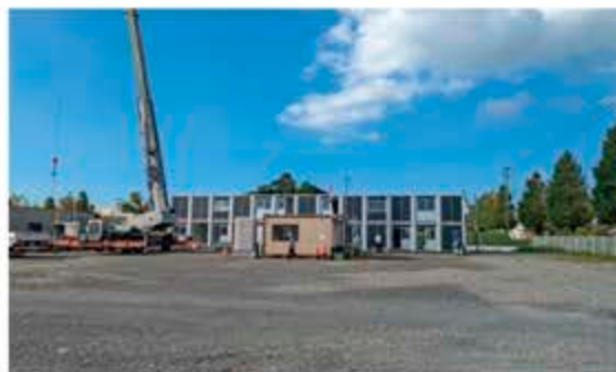
仮設事務所建設の様子
