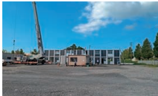
仮設事務所建設の様子
