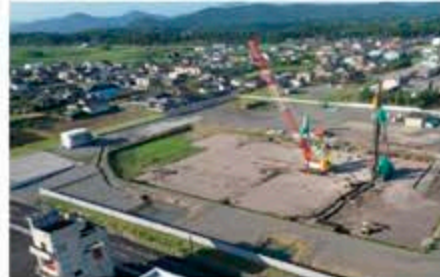
杭打ち作業の様子(10月下旬ごろ)
