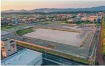
重機搬入前の様子(10月中旬ごろ)
