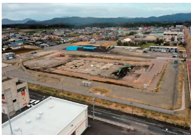
新庁舎建設工事現場の様子（全体）
