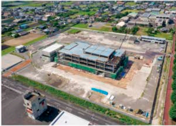
新庁舎建設工事現場写真（消防署側から）
