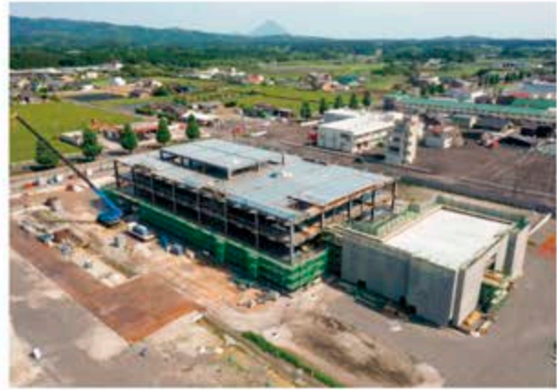
新庁舎建設工事現場写真（北側から）
