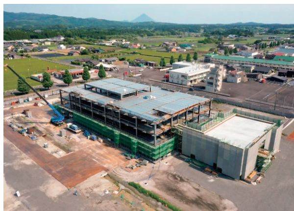
新庁舎建設工事現場写真（北側から）
