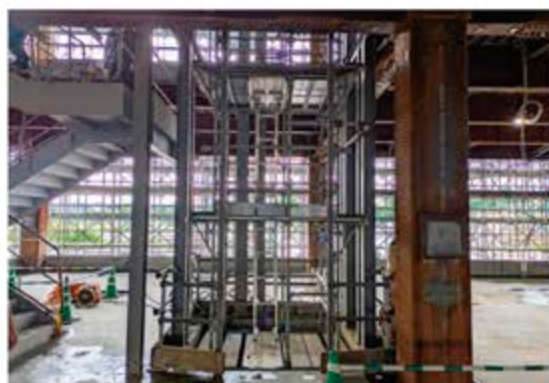
エレベーター枠組
