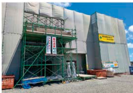
附属棟（西側から）
