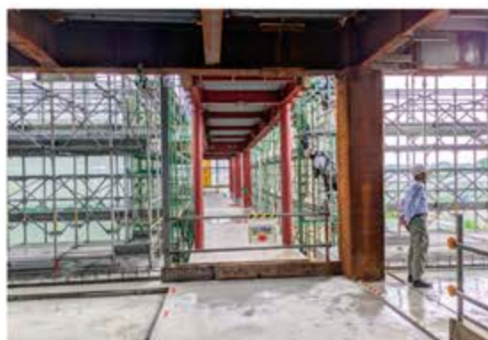
【2階】附属棟連絡通路
