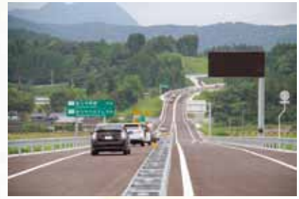
▲南薩縦貫道「川辺道路」開通
