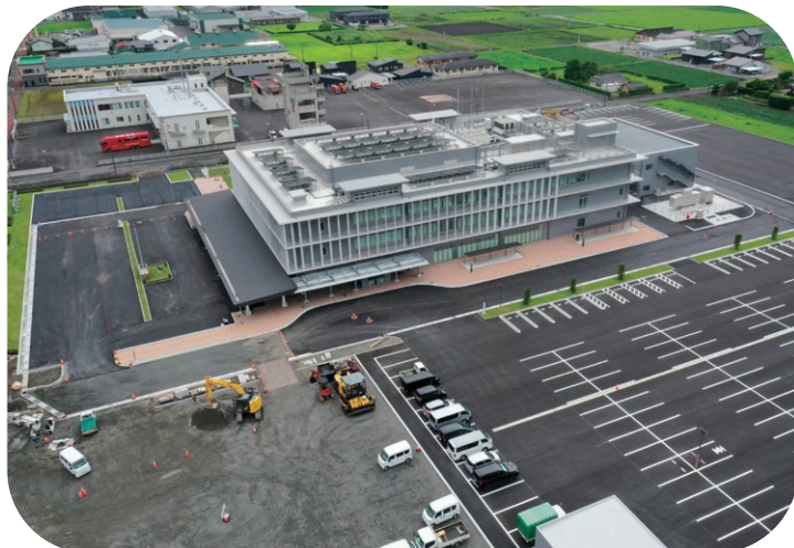
新庁舎建設現場の様子
