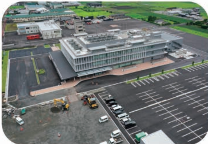
新庁舎建設現場の様子
