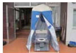
災害用マンホールトイレ
