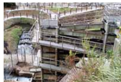
▲アユやモクズガニなどが万之瀬川を遡上できるよう魚道を整備しました。これらの魚道の完成により万之瀬川は河口から岩屋公園まで遡上したり、下ることができるようになりました。 魚道とは、ダムや滝などの障害物によって、魚などの往来が妨げられる場合に設ける通路。
