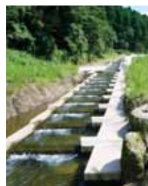
▲アユやモクズガニなどが万之瀬川を遡上できるよう魚道を整備しました。これらの魚道の完成により万之瀬川は河口から岩屋公園まで遡上したり、下ることができるようになりました。 魚道とは、ダムや滝などの障害物によって、魚などの往来が妨げられる場合に設ける通路。
