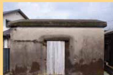
建物レンガ造りで、壁の表面はコンクリートでおおわれています。外壁にみられる円錐状の窪みは、昭和20年3月以降に、米軍機による空襲の際に受けた機銃掃射の痕跡と考えられます。太平洋戦争末期の様子をうかがうことができます。貴重な遺構です。
