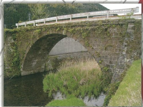
⑦旧木場田橋（石橋）
